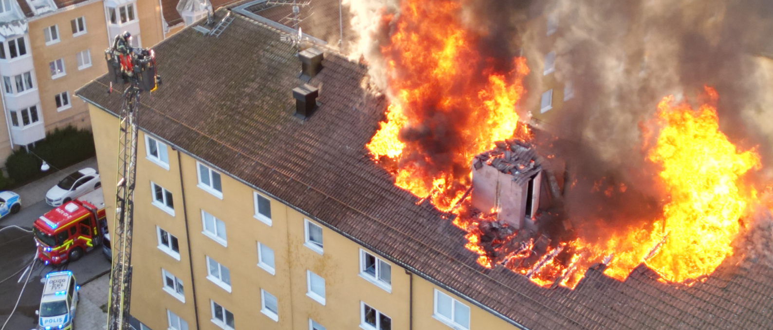
I juni 2023 orsakade en brand i en elsparkcykel omfattande skador i en fastighet på Luntgatan i Norrköping. En skada i batteriet orsakade termisk rusning vilket i sin tur ledde till en brandgasexplosion och ett intensivt brandförlopp. Branden spred sig snabbt i fastighetens vindsutrymmen. Foto: Ulf Wigh/Wighsnews.
