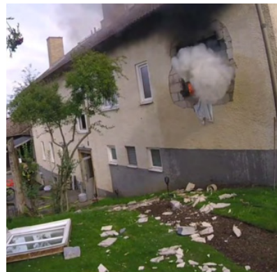
Lägenhetsbrand i flerbostadshus i Linköping i augusti 2023. Den troliga brandorsaken var överladdning i ett elcykelbatteri som började läcka. Foto: Räddningstjänsten.
