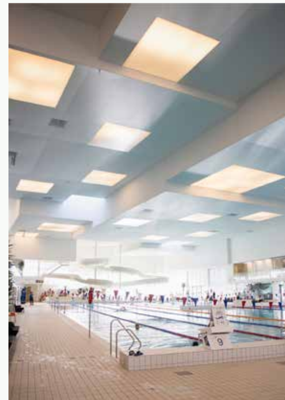
Detaljbild tak, AdO arena Bergen.
