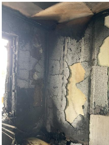
Figur 11. Brandskador i sovrum, lägenhet 2a.
