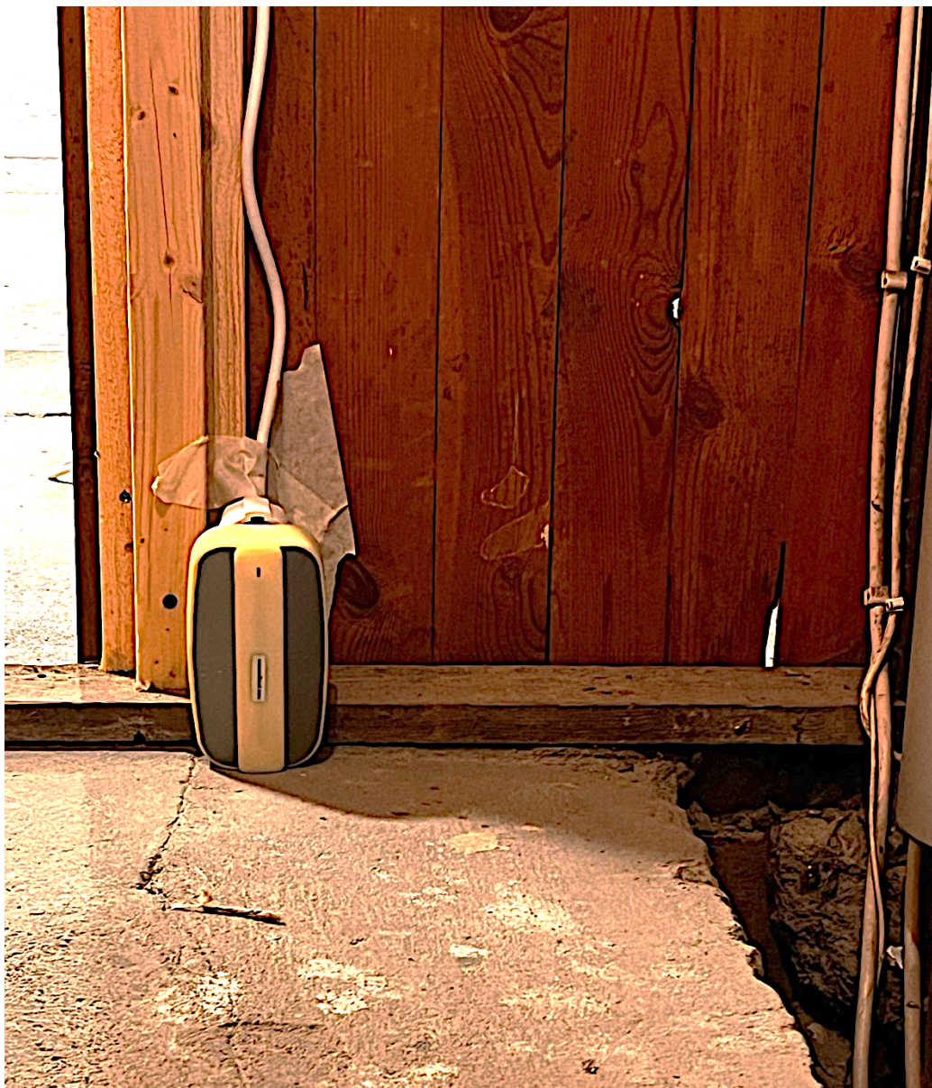
Figur 17 visar skrämman position precis bredvid installationsschaktet som ses till höger i bild. Skrämmen är satt i öronhöjd för en råtta.
