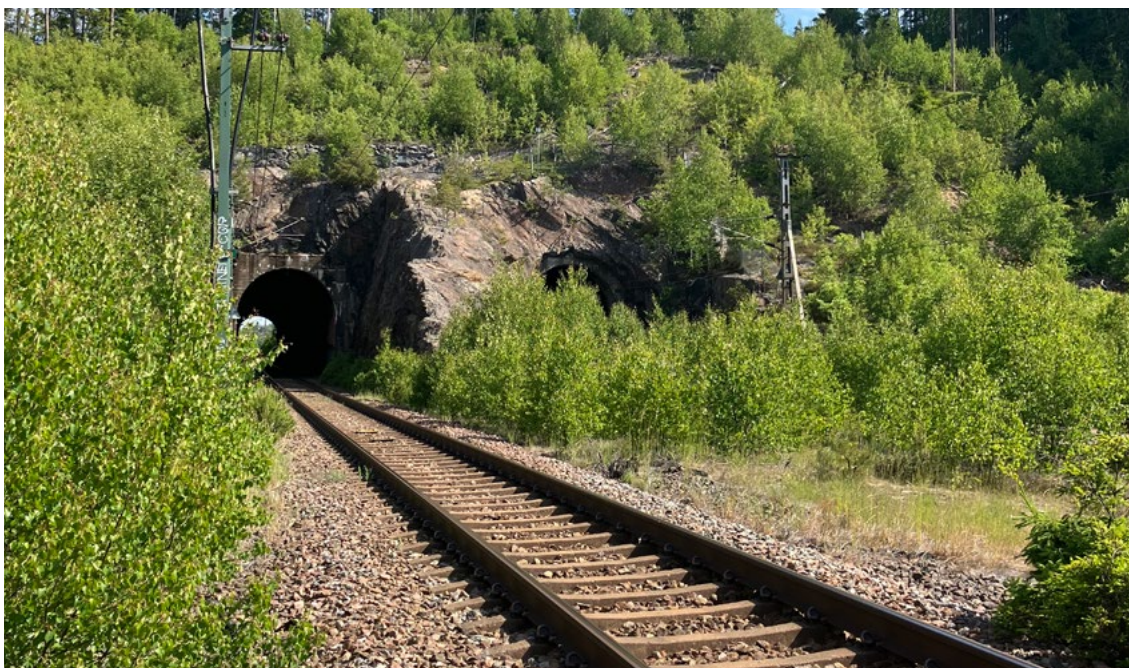
Tunnelmynning längs sträckan Flemingsberg–Järna. Foto: Trafikverket.
