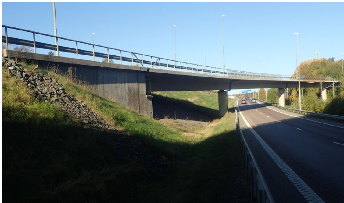
Trafikplats Trångsund. Foto:Trafikverket.
